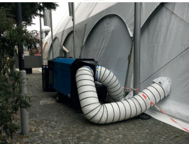
temporäres Heizungskonzept (ATP 500 Vienna)
