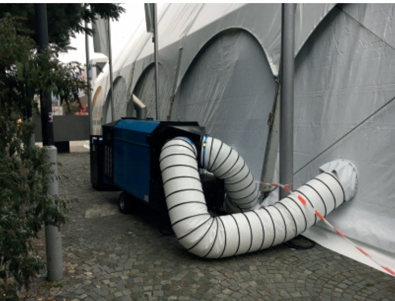
temporäres Heizungskonzept (ATP 500 Vienna)
